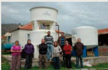
หม้อหมักก๊าซชีวภาพขนาด 30 กิโลวัตต์ ที่มา: Prof. Dr.Günur KÖVAR, Ege University, Institute of Solar Energy Turkey
